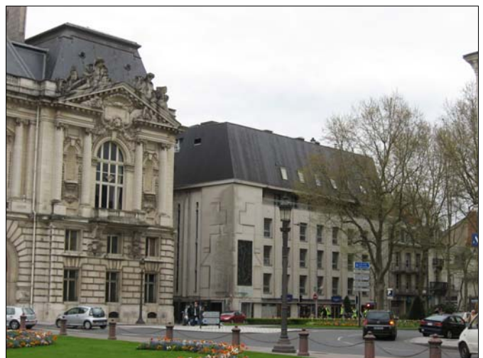
A droite, le site pressenti pour la Vélo-station, dans l'actuel parking Vinci.
